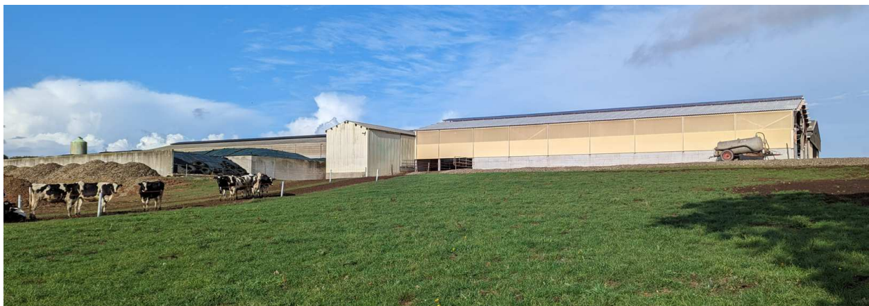
Vue depuis la prairie située au sud des installations
